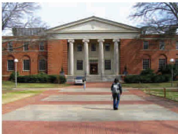
Zgrada Škole veterinarske medicine na UGA, glavni ulaz.
